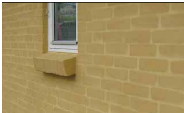
Eksempel på Murstensmønster/vandskuring
