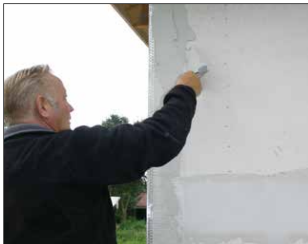
14. Alle hjørner forsynes med hjørneprofil, som fastgøres i Skaltherm Grundpuds eller Multiklæb®.
