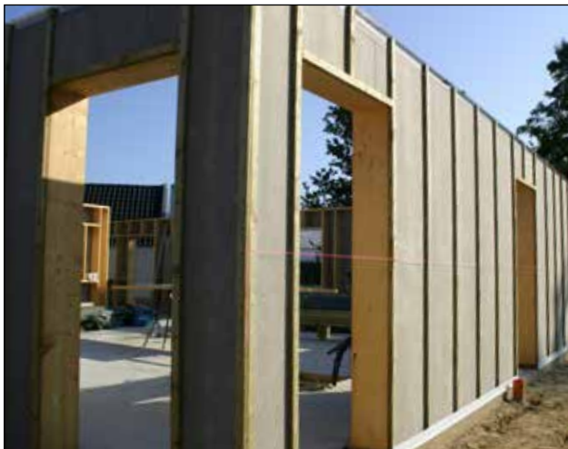
1. Der er monteret klemfliser uden på vindspærren, og samtidig er udluftningsprofil og kantprofil monteret.
