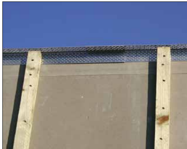
2. Udluftningsprofilen skal overlappe ved samlinger.
