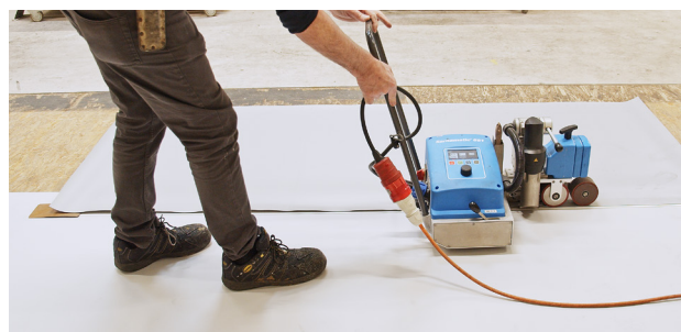
4. Automatisk varmluftsvejsning af Sarnafil® FPO-membran på SikaRoof® Multitape.
