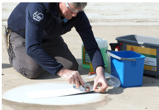
8. Fastgørelse af SikaRoof® Multitape med trykrulle.
