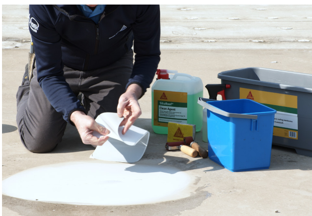
7. Fjern aftræksforingen med fingeraftrækket.
