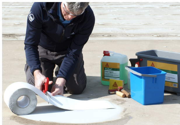
6. Skær SikaRoof® Multitape til i den ønskede længde.
