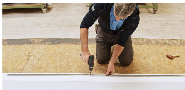
2. Montering af Sarnabar®-fastgørelsesprofil med Sarnafast®-fastgørelseselementer og Sarnafil® T-svejsesnor.
