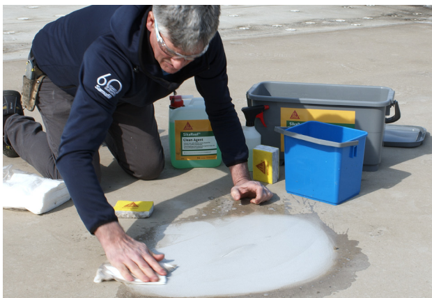
5. Korrekt rengøring af det eksisterende område, der skal repareres (som forklaret under RENGØRING).
